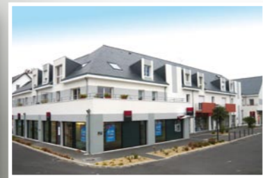
Sautron immeuble de logements et commerces GO 700 k€
