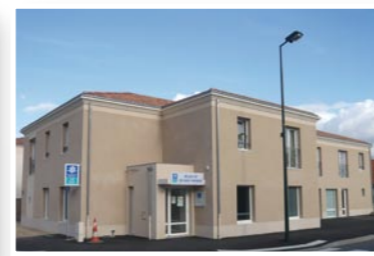
St Philbert de Gd Lieu immeuble de bureaux et logements - GO 154 k€
