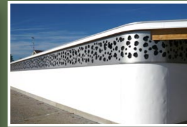
Bouguenais extension groupe scolaire - GO 170 k€
